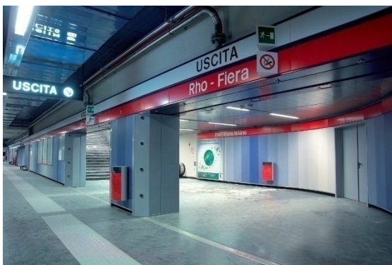
ESTACION DE METRO / ITALIA
