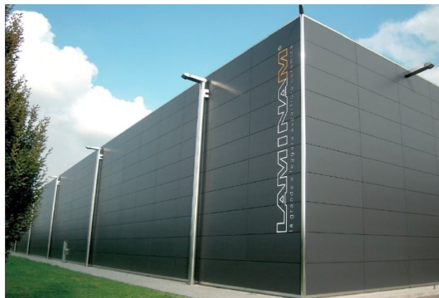
FACHADA EMPRESA LAMINAM
